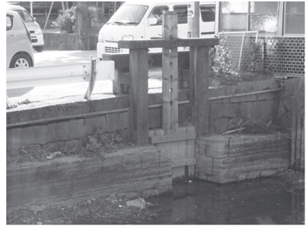
図3-8 樋管と差蓋 (2015.12.18撮影)
