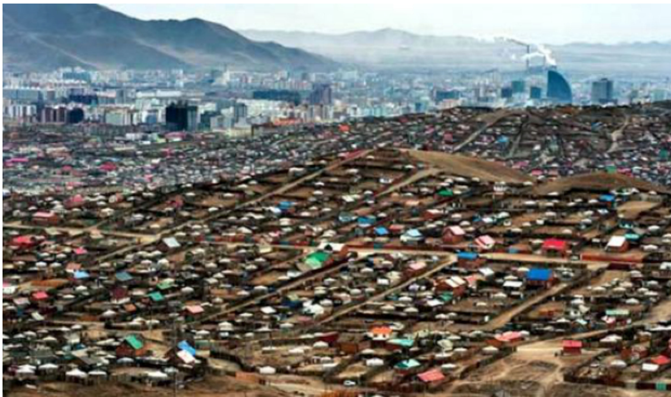
写真2. ウランバートル市の全景（奥が開発の進む市の中心部、手前がゲル地区）
